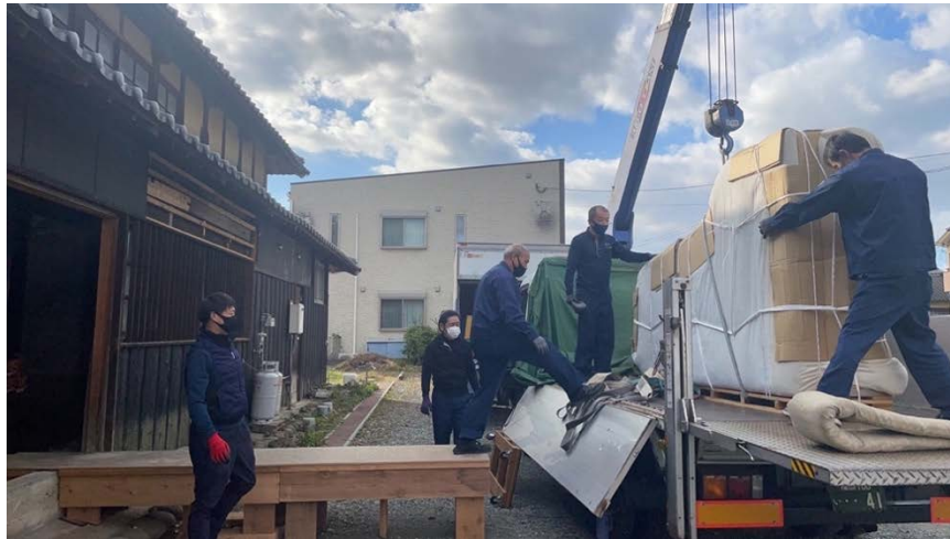
speciaal voor het concert werd een laadbrug gebouwd om de Kawai-vleugel in het gebouw te transporteren
